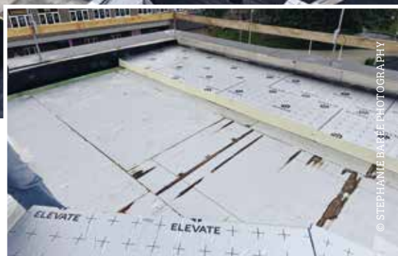
VBS de Bron in Wellen: eerste laag gerecupereerde isolatie met erboven nieuwe isolatie
