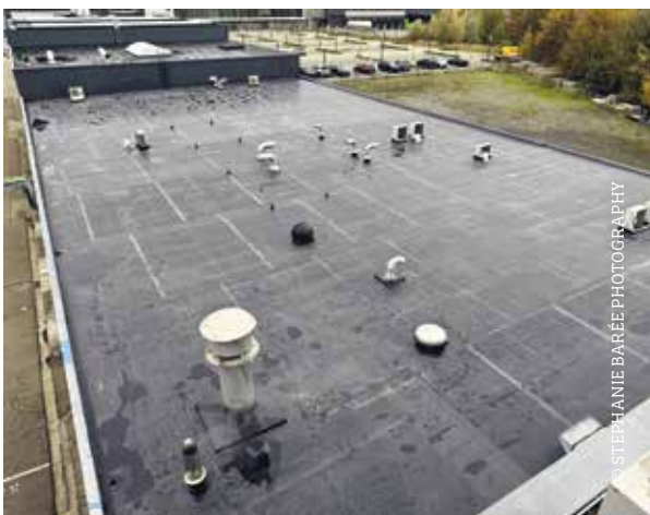
Solithor in Sint-Truiden: dakrenovatie
